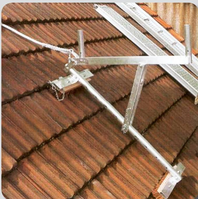
Fissare la slitta ad una trave di sezione minima di circa 38 x 200 mm in modo di ottenere un supporto ottimale di incollaggio. Fissare la slitta con una corda in poliammide Ø 16 mm (DIN EN 354). Dopo aver tolto le tegole e montato le slitte, è possibile riposizionare le tegole in modo da evitare infiltrazioni. La sezione a U della slitta permette il montaggio del trabattello.
