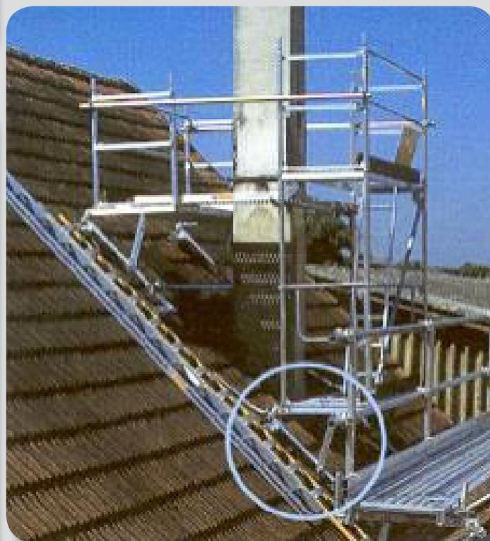
Esempio di montaggio di 2 Trabattelli Tempo Tech con 4 slitte
