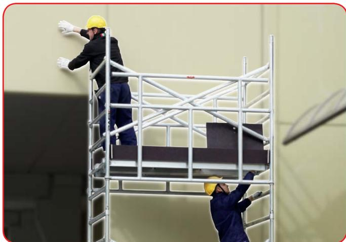
**Ringhiera di protezione:** i parapetti SAFE formano insieme alle spalle con gradini una ringhiera di protezione regolamentare senza l'utilizzo di un modulo terminale. Ciò riduce i componenti ed i tempi di montaggio. Tempo Safe è ideale per i Noleggiatori.
