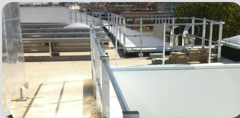
Esempio di Parapetto modello PC1A con fissaggio a pavimento
