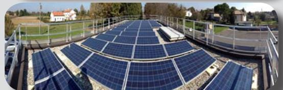
Parapetto smontabile per utilizzo temporaneo in cantiere al posto dei parapetti in legno più complessi o impossibili da fissare a muro o soletta in certe situazioni.
