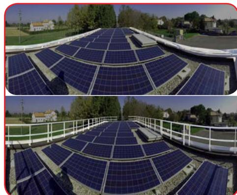
**FOTOVOLTAICO:** i modelli reclinabili sono perfetti per i tetti su cui sono montati impianti fotovoltaici in quanto restano sempre chiusi evitando l'ombreggiamento. Il parapetto viene aperto dall'operatore solo prima delle operazioni di manutenzione e poi chiuso nuovamente.
