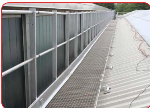
Passerelle montate per ispezione pannelli fotovoltaici
