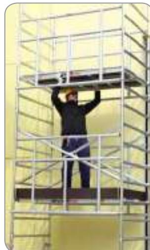
7. Se coloca la plataforma por debajo de la barandilla instalada
